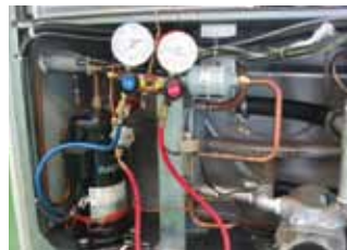
⑤冷媒圧力測定
