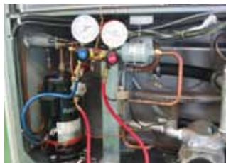
⑤冷媒圧力測定
