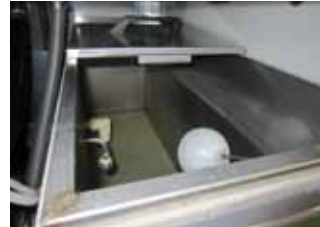
③水槽・Y型ストレーナの清掃
