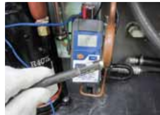
⑥冷媒配管温度測定
